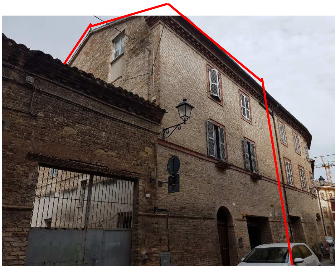
Foto 02 Prospetto Nord-Ovest (via Valporro)
